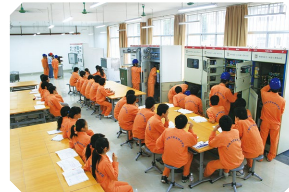
我校学生在10kv配电室开展变配电开关设备实训
